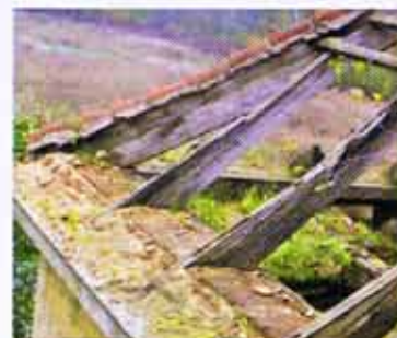
TRÓJKĄTNE NADBITKI NA KROKWIACH PRZY DOLNEJ KRAWĘDZI DACHU, PODOBNE NADBITKI TWORZĄ PSEUDO PRZELAMANIE DACHU
