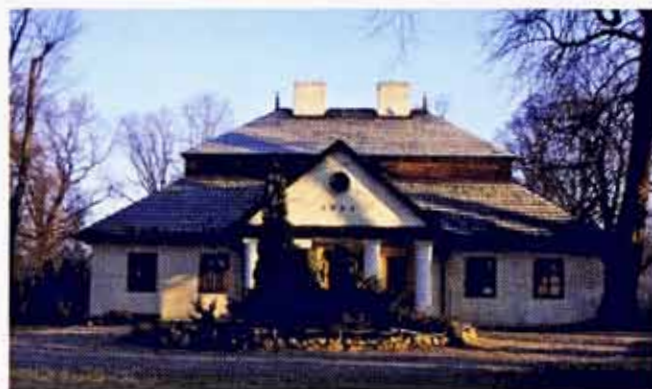
KRZYKAWKA, STAN OBECNY, WYREMONTOWANY W LATACH 1984-1989
