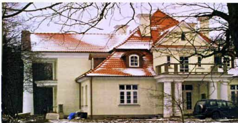
TRÓJKĄTNE NADBITKI NA KROKWIACH PRZY DOLNEJ KRAWĘDZI DACHU, PODOBNE NADBITKI TWORZĄ PSEUDO PRZELAMANIE DACHU
