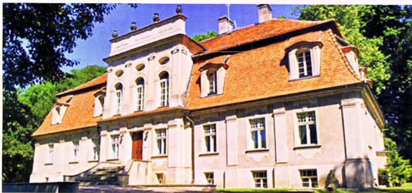
POPOWO STARE 1775-1785 R., ARCH. IGNACY FRAFF
