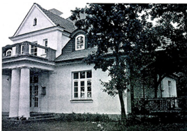
Zakończona odbudowa, dwór widoczny od strony starego wejścia.
