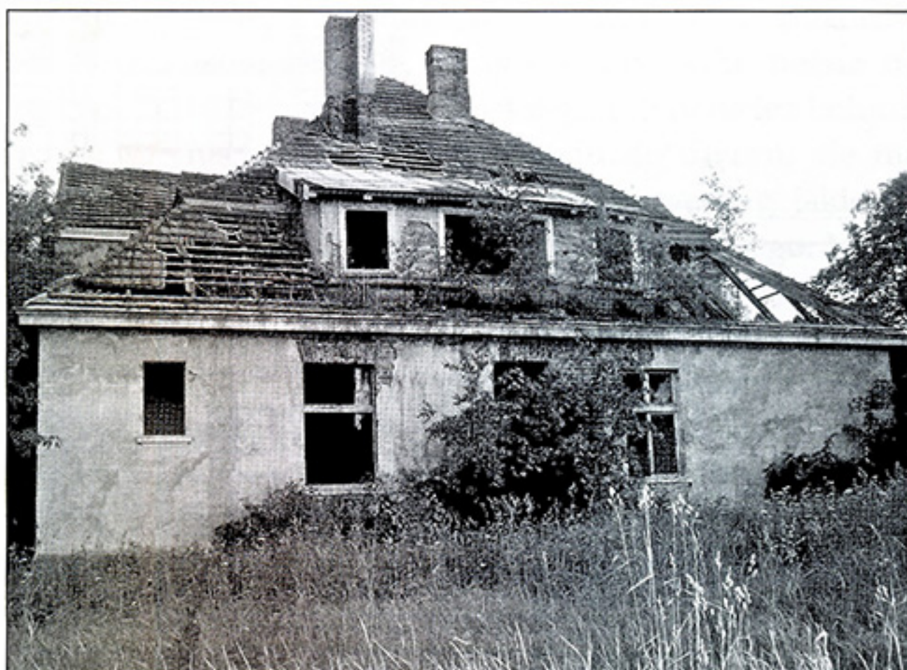
Elewacja północna stan zastany
