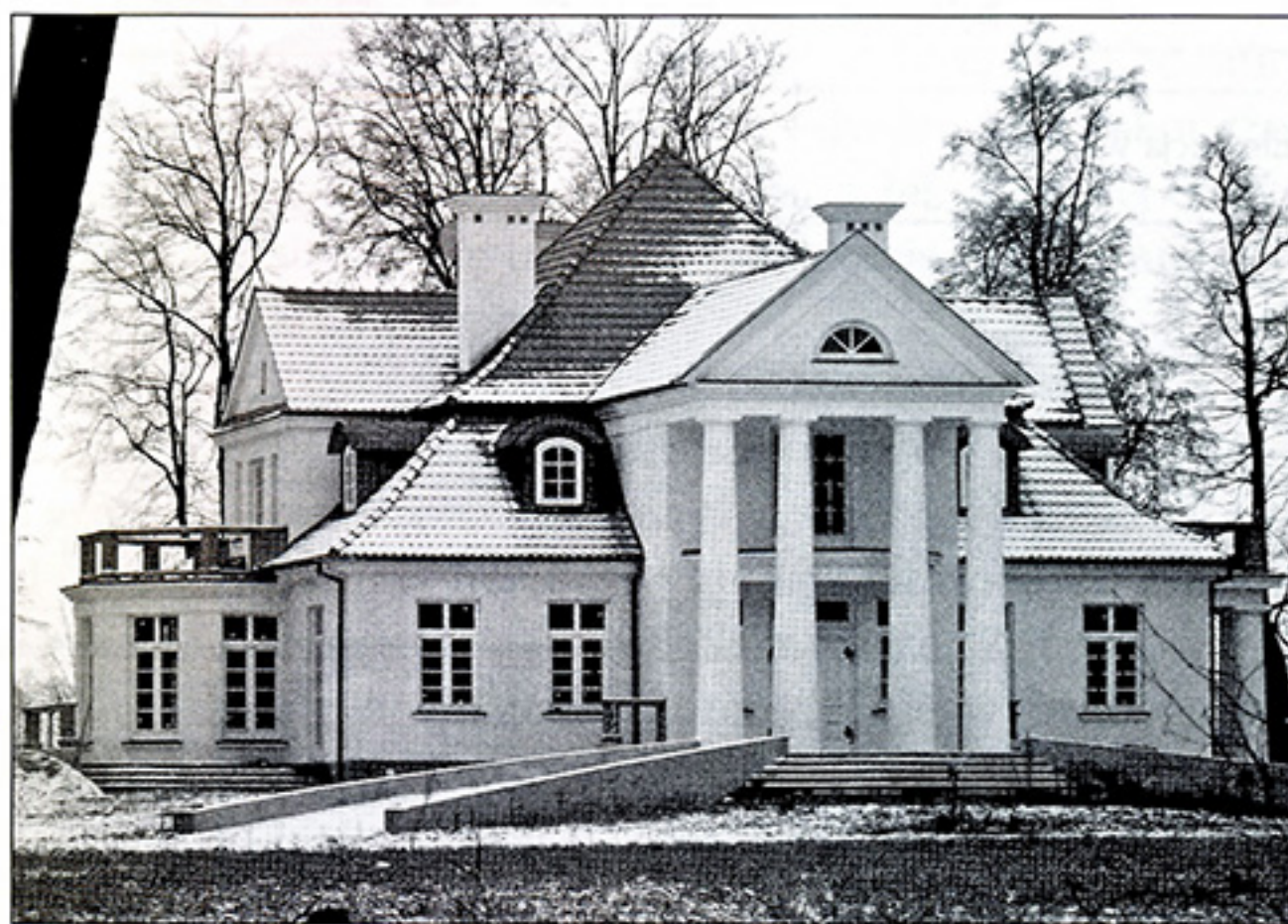
Elewacja północna po przebudowie
