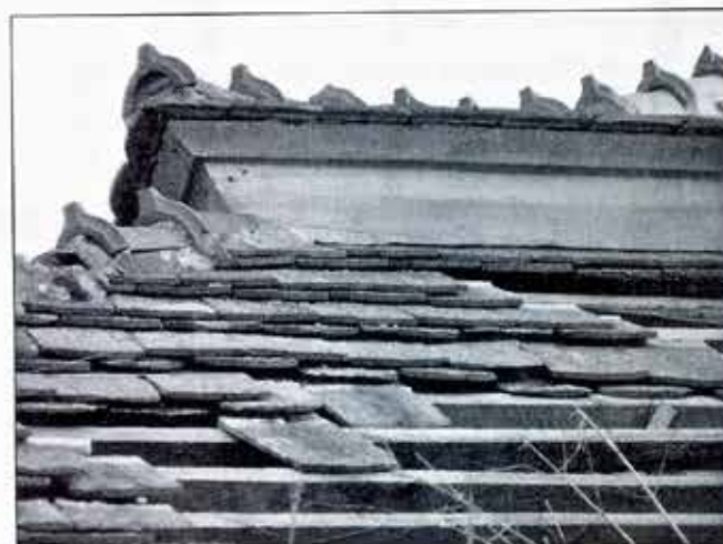
Detal wykończenia krawędzi przełamania dachu pseudołamanego
